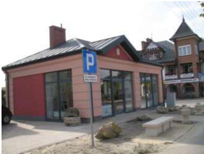
Pawilon geoturystyczny na „Szlaku geoturystycznym Roztocza Środkowego”
